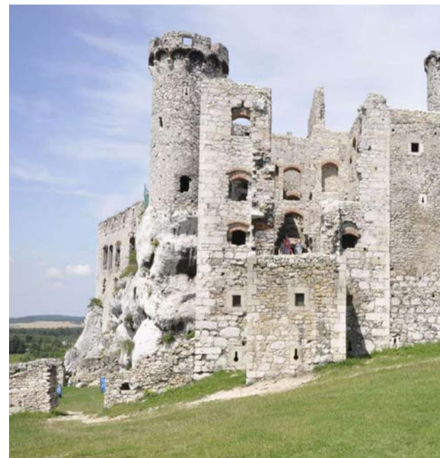
Czy tego typu obiekty, jak słynny zamek w Ogródzieniu będą narażone na uszkodzenie, gdy powstanie kopalnia i lej depresyjny o średnicy 7 kilometrów?
